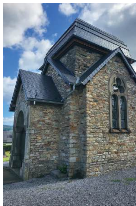
Rénovation de la toiture de la morgue de Vielsalm
