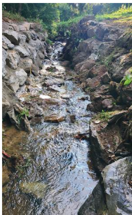
Travaux de renforcement de berges de ruisseaux
