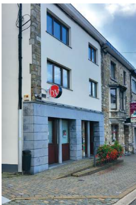
Rénovation de la toiture (y compris pose de PV) et de la façade de la Bibliothèque Publique de Vielsalm
