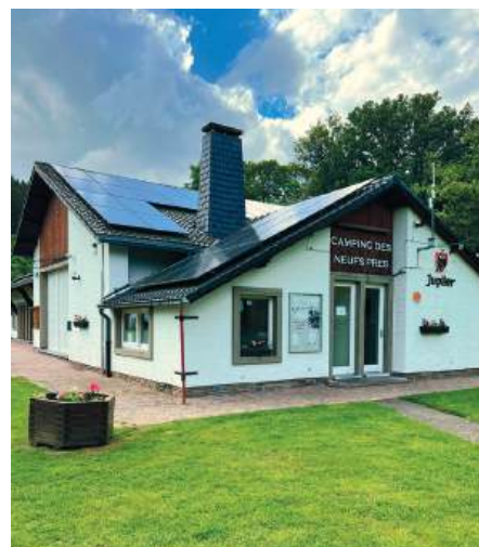
Placement de panneaux photovoltaïques sur des bâtiments communaux (camping de Grand-Halleux)
