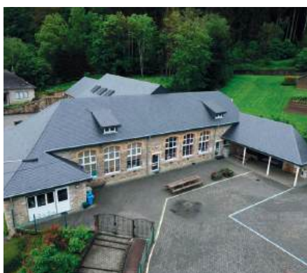
Réfection et isolation de la toiture de l'école communale de Salmchâteau - création d'un espace psychomotricité dans les combles
