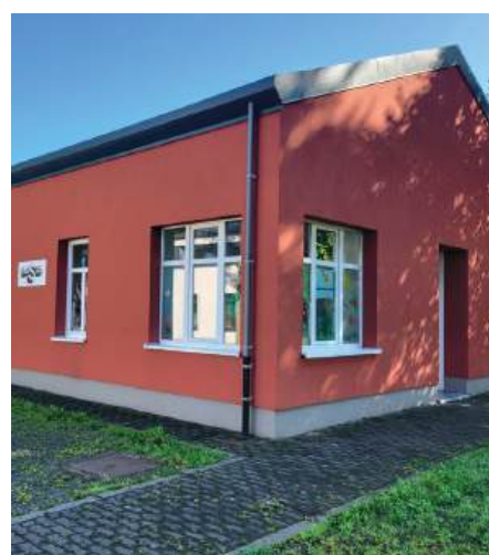
Rénovation énergétique de bâtiments à la caserne Ratz de Rencheux
