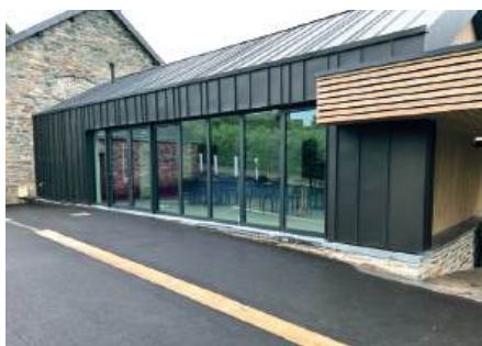
Extension de l'école communale de Hébronval
