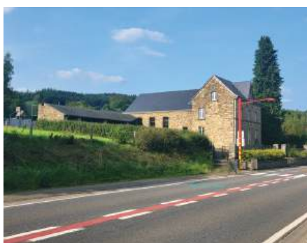
Réfection et isolation de la toiture de l'école communale de Petit-Thier
