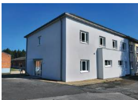
Rénovation du bloc C à la caserne Ratz de Rencheux et création de 5 logements d'insertion gérés par le CPAS
