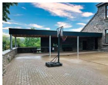
Extension du préau et réfection de la cour de l'école communale de Goronne
