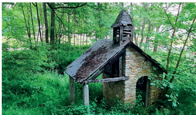
Rénover la chapelle Saint-Gengoux à Vielsalm.
